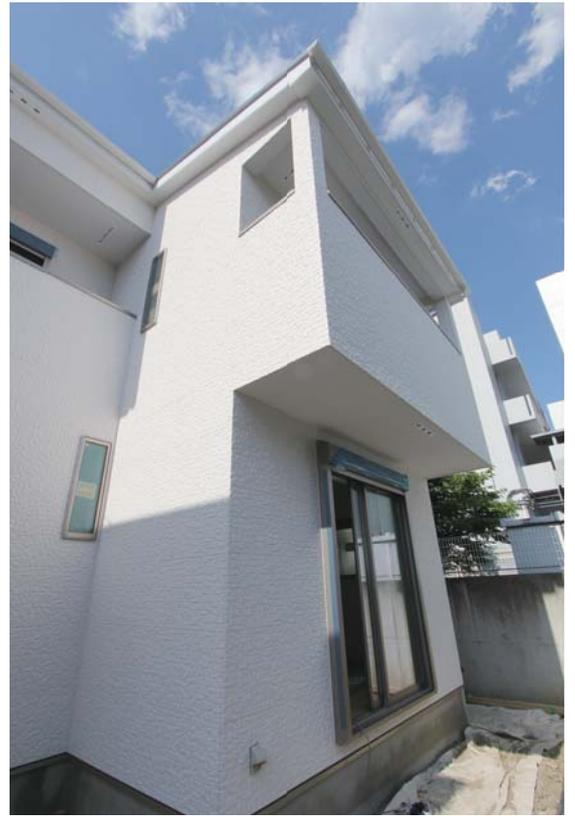
**R** カドアールとは サイディング端部を R 加工して表面と同じ意匠に仕上げたコーナーレス部材です。
